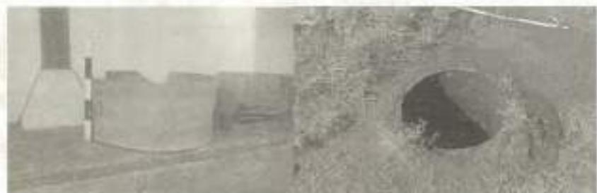
Foto 6.16 Dinding sumur terakota (*jobong*) (kiri) dan pemasangannya (kanan).
